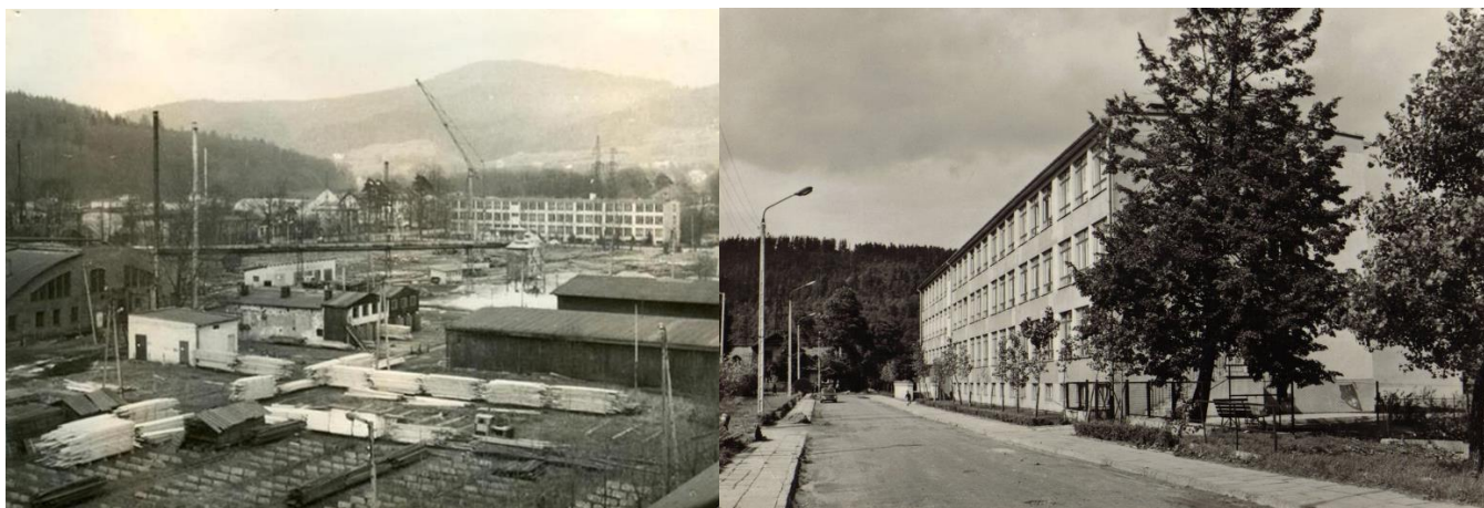
Budowa (na pierwszym planie tartak) i nowy budynek Liceum przy ul. XX-lecia PRL
